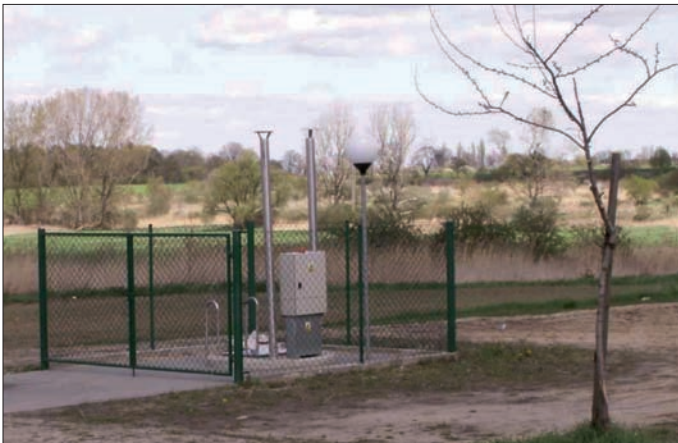
Rys. 4 Szafka sterownicza przepompowni wyposażona są w zaprogramowane moduły telemetryczne MT-101. W każdym z modułów telemetrycznych zainstalowana jest karta SIM wybranego operatora sieci komórkowej (T-MOBILE, ORANGE lub PLUS) posiadająca statyczny adres IP, aktywowana w bezpiecznym, prywatnym APN telemetria.pl.
