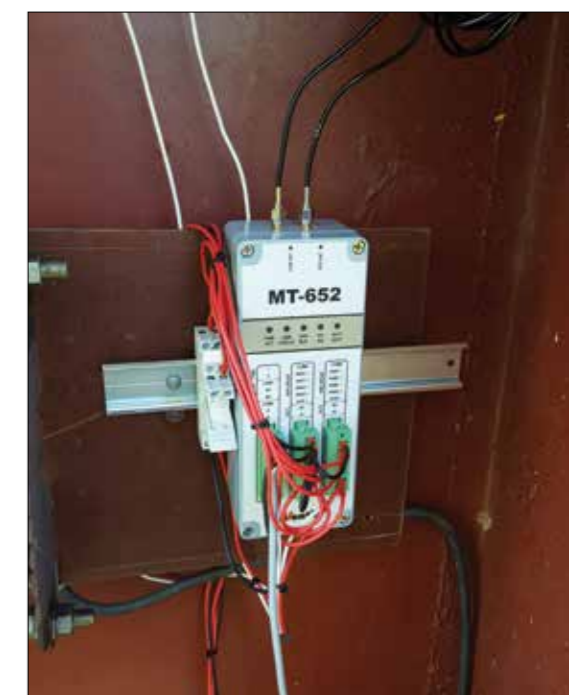
Widok modułu MT-652 zamontowanego w szafie drenażu polaryzowanego
