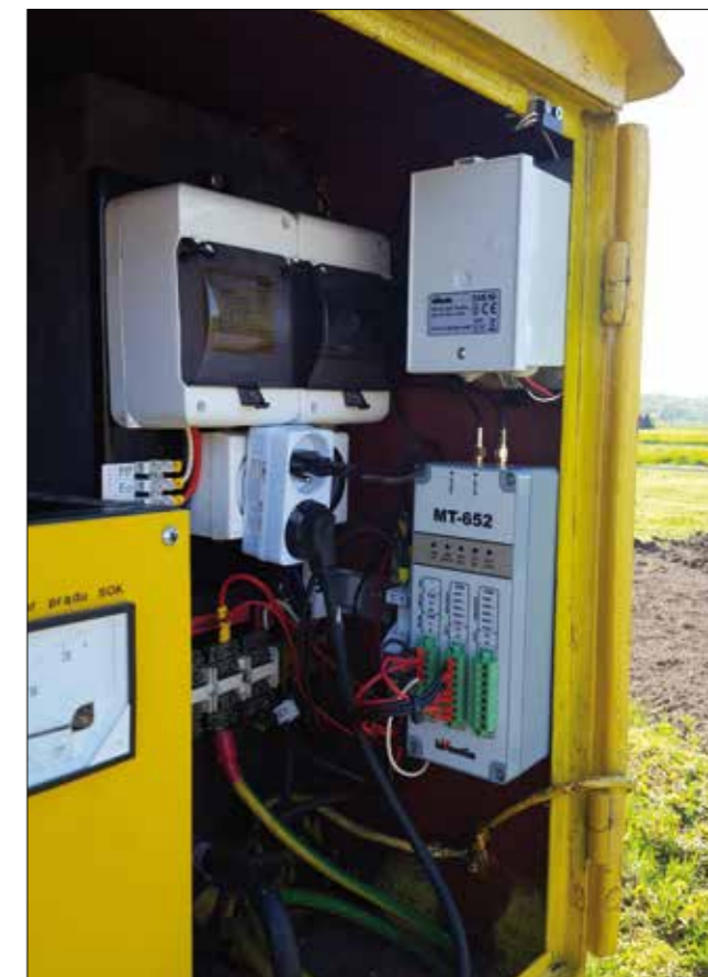
Widok modułu MT-652 zamontowanego w szafie stacji ochrony katodowej
