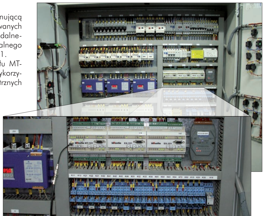
Zdjęcia szafy sterowniczej z zainstalowanymi modułami telemetrycznymi
